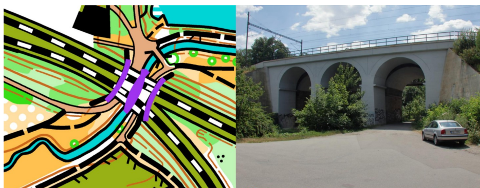
místo, kde tratě podbíhají železnici
